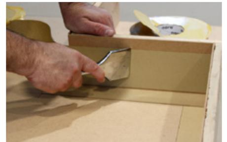
3. 使用踢脚线包角的阴阳角前先使用一条踢脚线(宽度至少为10厘米) 检查它们的角度是否正确。或者, 也可以使用方形框架校准。
