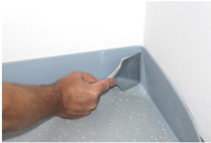
9. 在使用强力胶粘贴两个踢脚线之间的连接部位时，必须把它们置于一个坚硬、平整的表面上进行粘贴，以避免出现缝隙。
