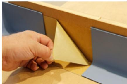
8. 然后按压踢脚线和踢脚线包角, 并使用一个浅色橡皮槌敲击 密实。
