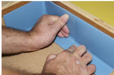
4. 使用浅色橡皮槌朝墙壁和地面方向轻击踢脚线包角。
