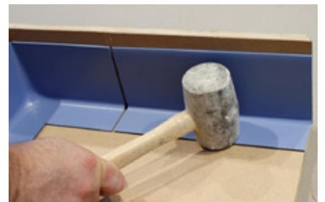
9. 使用nora<sup>®</sup>1K冷焊剂焊接阴阳角。在安装完毕和使用nora<sup>®</sup>液体蜡 (参见“焊接”处理推荐) 打蜡后可即刻填焊。
