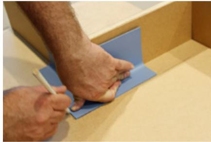
2. 在粘贴踢脚线 and 踢脚线包角时, 我们建议使用nora<sup>®</sup>Profix90 \* 粘贴墙面, 使用nora<sup>®</sup>Profix50 \* 粘贴地面。
