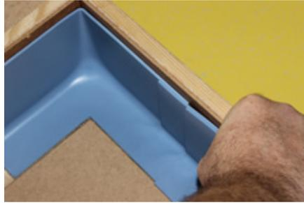
6. 由于踢脚线包角和踢脚线之间的接合处必须密封, 并且将踢脚线放在这种角度上, 从而形成2-3毫米的接缝距离。用直刀片沿着踢脚线“标尺”, 然后移除“标尺”后, 突出的部分被切掉。这样连接的地方非常整齐。
