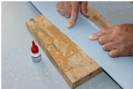
10. 使用压边铲来回推压型材，并使用一个浅色橡皮槌朝墙面方向敲打。
