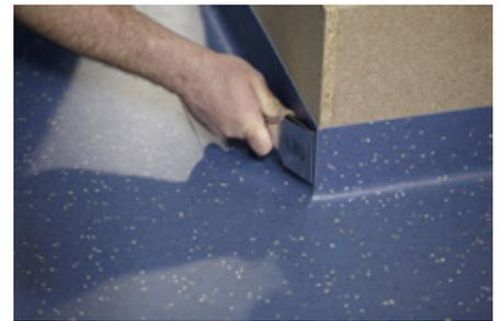
12. Die Nähte zum Bodenbelag müssen verfugt werden. Hierfür kann nach 24 h eine Verschweißung mit nora<sup>®</sup> Thermoschnur oder gleich nach der Verlegung eine Verfugung mit nora<sup>®</sup> 1-K-Fugenmasse erfolgen (s. Verarbeitungsempfehlung „Verfugung“).
