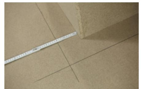
2. noraplan<sup>®</sup> auslegen und die Nähte schneiden. Klebstoff bis zur Markierung exakt auftragen und nach dem Ablüften den Belag einlegen.
