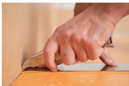
3. L'expérience a montré comment séparer les bandes de revêtement inférieures rainurées avec une lame croche. La découpe avec une coupe sous le bord après la pose du revêtement est déconseillée car il existe un danger de pressage de joint.
