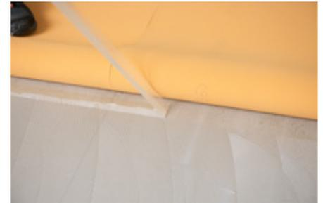
6. La colle à utiliser est une colle acrylique. Nous recommandons l'utilisation de nora<sup>®</sup> AC 100 \*. Appliquez la colle à l'aide de la spatule dentelée recommandée par le fabricant.
