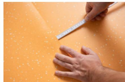
2. Redressez le bord découpé en usine à l'aide du coupe joint nora<sup>®</sup> le long d'une règle en acier (env. 1 cm du bord découpé en usine), ce qui permet de découper la bande en dessous, c'est-à-dire de la fendre légèrement. Une découpe de rail (Wolff) peut être utilisée à la place du coupe joint nora<sup>®</sup>. Cependant, une linogravure ("Linocut") n'est **pas** adaptée.
