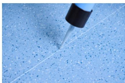
5. Die eingespritzte Fugenmasse wird unmittelbar nach dem Ausspritzen mit der flachen Seite des nora<sup>®</sup> Glättspatels in die Fuge gedrückt und geglättet. Die überschüssige Fugenmasse wird dabei links und rechts neben die Fuge gedrückt. Es ist darauf zu achten, dass eine Trennung der Fugenmasse in der Fuge von dem zur Seite gedrängten Material erfolgt. Spatel möglichst flach halten, da sonst Hohlfugen entstehen.
