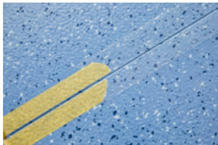
4. Frässpäne entfernen (absaugen).
