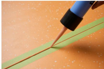
5. Die eingespritzte Fugenmasse wird unmittelbar nach dem Ausspritzen mit der großen Rundung des nora<sup>®</sup> Glättspatels in die Fuge gedrückt und geglättet. Die überschüssige Fugenmasse wird dabei links und rechts neben die Fuge gedrückt. Es ist darauf zu achten, dass eine Trennung der Fugenmasse in der Fuge von dem zur Seite gedrängten Material erfolgt. Spatel möglichst flach halten, da sonst Hohlfugen entstehen.
