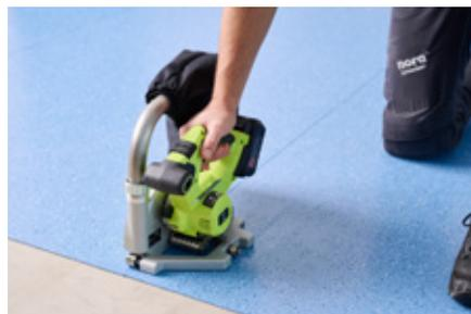
3. Frässpäne entfernen (absaugen).
