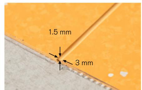
2. Frässpäne entfernen (absaugen).
