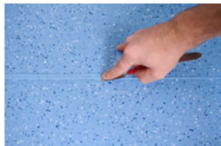
6. 可以在大约12小时后去除被挤压至两边的冷焊剂。
