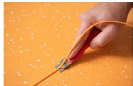
8. 在热焊条冷却后，使用莫扎特铲刀不带垫片进行第二次铲焊。
