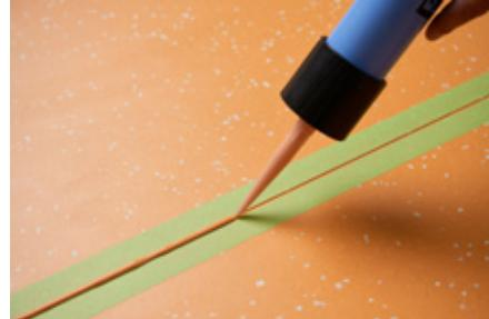
5. 涂抹后, 立即将冷焊剂压入接缝中, 并用诺拉<sup>®</sup>平滑抹刀的大圆弧形抹平。这样, 多余的冷焊剂就会被压向接缝的左右两侧。尽可能平放抹刀, 以避免出现空心焊缝。
