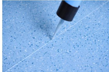
5. 在注入完成后应该立即使用刮刀把被注入的冷焊剂压入接缝，并刮平缝口。将多余的冷焊剂挤压到接缝的左右两侧。必须注意，刮平后溢出的冷焊剂要和缝隙脱离。尽可能低压刮刀，否则会出现接缝空鼓。
