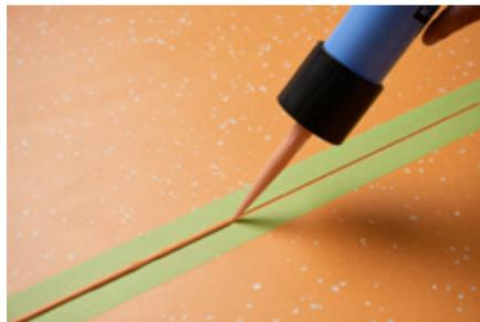
5. Immédiatement après l'application, la soudure à froid est pressée dans le joint et lissée avec l'extrémité arrondie de la spatule de lissage nora<sup>®</sup>. Ainsi, le surplus de pâte de vulcanisation est pressé à gauche et à droite du joint. Tenez la spatule dans une position aussi plate que possible pour éviter le développement de joints creux.
