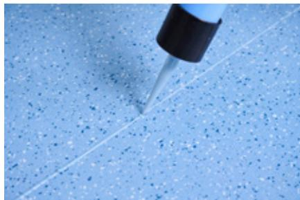
5. La pâte de vulcanisation injectée est pressée et uniformisée après l'éjection dans le raccord avec la spatule à lisser nora<sup>®</sup>. L'excédent de pâte de vulcanisation est poussé à gauche et à droite. Il faut veiller à ce que le mastic se sépare du matériau poussé de côté. Veiller à maintenir la spatule à plat pour éviter la formation de joints.
