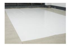
3. Die nora dryfix 750-Überlappungen im Nahtbereich entweder mit Hilfe eines Lineals an der unteren Kante entlang beschneiden oder mit Unterkantenschnitt bearbeiten. Dabei ist darauf zu achten, dass keine Fehlstellen breiter als 2 mm entstehen.
