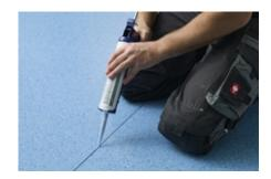
5. Die eingespritzte Fugenmasse wird unmittelbar nach dem Ausspritzen mit dem nora® Glättspatel in die Fuge gedrückt und eben abgezogen. Die überschüssige Fugenmasse wird dabei links und rechts neben die Fuge gedrückt. Es ist darauf zu achten, dass eine Trennung der Fugenmasse in der Fuge von dem zur Seite gedrängten Material erfolgt. Spatel möglichst flach halten, da sonst Hohlfugen entstehen.
