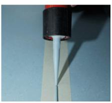
5. Die eingespritzte Fugenmasse wird unmittelbar nach dem Ausspritzen mit der großen Rundung des nora® Glättspatels in die Fuge gedrückt und geglättet. Die überschüssige Fugenmasse wird dabei links und rechts neben die Fuge gedrückt. Spatel möglichst flach halten, da sonst Hohlfugen entstehen.
