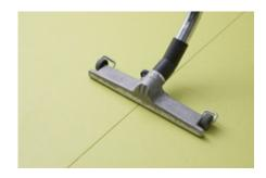
4. Die Thermoschnur kann mit dem Handschweißgerät mit aufgesteckter Schnellschweißdüse (bei noracare® mit schmalem Luftaustritt) oder dem Schweißautomaten mit Teflonrolle verarbeitet werden. Die Arbeitstemperatur der Geräte ist erreicht, wenn die Thermoschnur links und rechts am Fugenrand etwas herausquillt.
