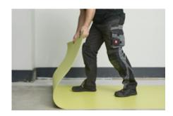
6. Schutzpapier von nora dryfix 750 entfernen und bis auf ca. 10 cm abschneiden. Diese 10 cm umklappen und unter den zurückgeschlagenen Belag schieben. Dabei ist sicherzustellen, dass keine Schmutzpartikel in die Klebstoffschicht gelangen.
