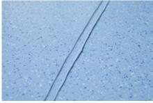
**6.** Die zur Seite gedrückte Fugenmasse kann nach ca. 12 Stunden entfernt werden.
