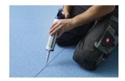
5. Presionar el sellador inyectado inmediatamente después del rociado con la espátula plana nora® sobre la junta y alisar. Empujar el exceso de sellador hacia la derecha y hacia la izquierda de la junta. Asegurarse de que el sellador en el interior de la junta se separa del material empujado hacia los lados. Mantener la espátula lo más recta posible para que no se produzcan juntas huecas.
