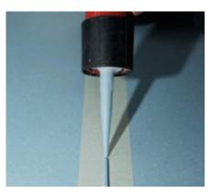
5. Inmediatamente después de aplicar el sellador en frío, se presiona uniformemente sobre la junta y se alisa con la forma grande y redonda de la espátula de alisado nora. De esta forma, el exceso de sellador en frío se presiona a la izquierda y a la derecha de la junta. Mantenga la espátula en una posición lo más plana posible para evitar que se formen juntas huecas.
