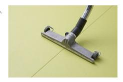
4. El cordón sellador en caliente se coloca utilizando el dispositivo manual de selladura con boquilla de soldadura rápida (para noracar™ con pequeño orificio de ventilación) o un dispositivo de selladura automático con rollo de teflón. La temperatura de operación del dispositivo se alcanza cuando el cordón sellador en caliente sobresale ligeramente por los bordes izquierdo y derecho de la junta.
