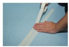
4. Primero selle las juntas en una dirección. Después de que el sellador en frío se haya secado, selle las juntas en la otra dirección. Para ello, el sellador en frío de un componente se extiende por las juntas sin dejar huecos hasta que se forma un pequeño relieve sobre la junta.
