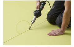
5. La temperatura de funcionamiento está entre 350-400 °C (por noracare máximo 300 °C). Al procesar el cordón sellador con dispositivos de selladura automáticos, la velocidad deberá ajustarse a aprox. 2 m lineales/min. Tanto la velocidad como la temperatura pueden regularse en la mayoría de los dispositivos automáticos.
