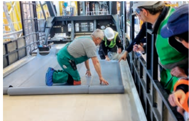
Verlegung von nora® nTx
